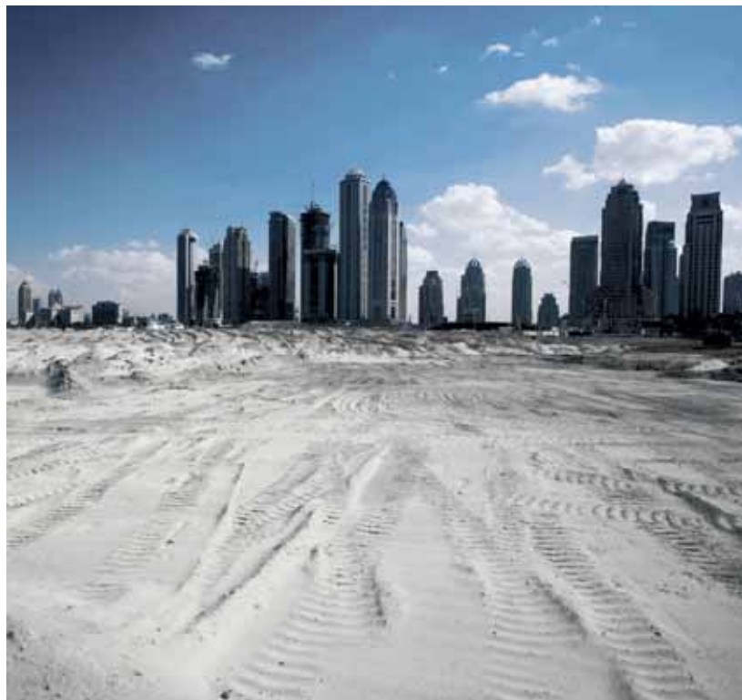
Un chantier interrompu. Au temps du boom immobilier, Dubaï abritait le cinquième de toutes les grues du monde. © MATILDE GATTONI/ARABIANEYE/REA
